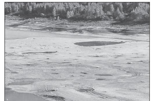
**I fanghi depositatisi nel corso degli anni nella diga del Camastra, a causa dell'assenza di manutenzione**
