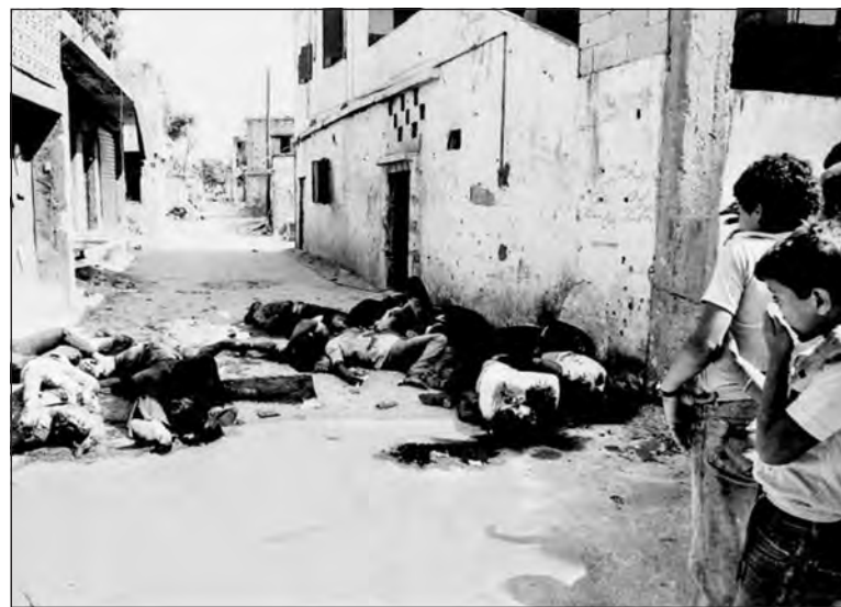
Vittime della strage di Sabra e Chatila, settembre 1982
